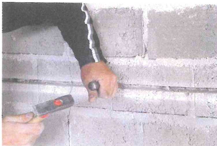
Rys. 7. Czyszczenie i wyrównanie bruzdy (rysunek poglądowy) [6-17].
