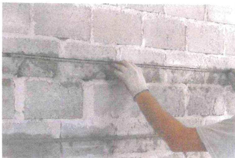
Rys. 8. Osadzenie pręta w bruzdzie muru (rysunek poglądowy) [6-17].
