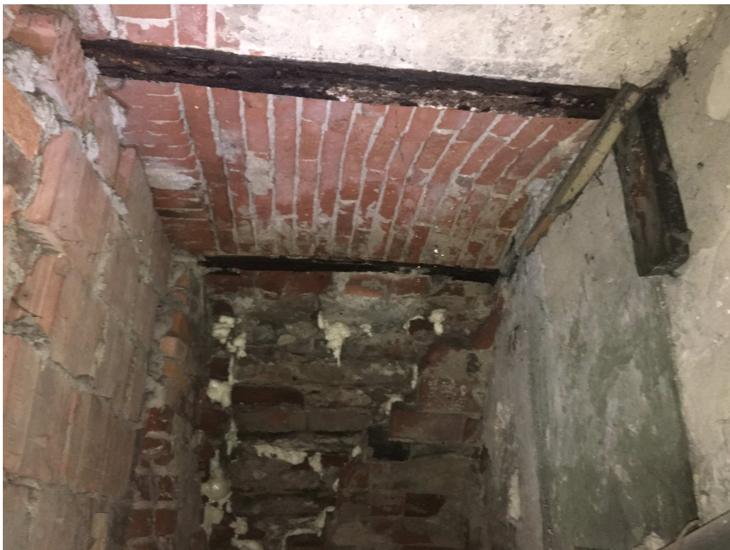
Zdjęcie górnej części sklepienia ceglanego biegu schodów
