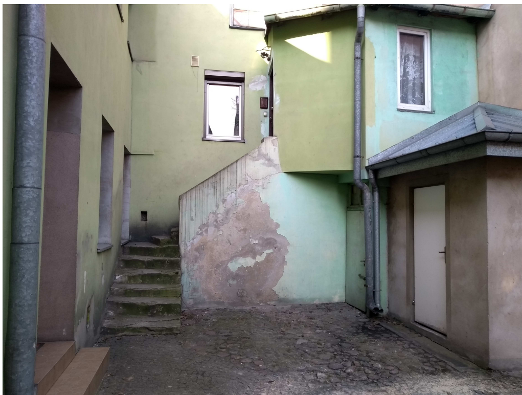
Zdjęcie ogólne schodów od strony południowej
