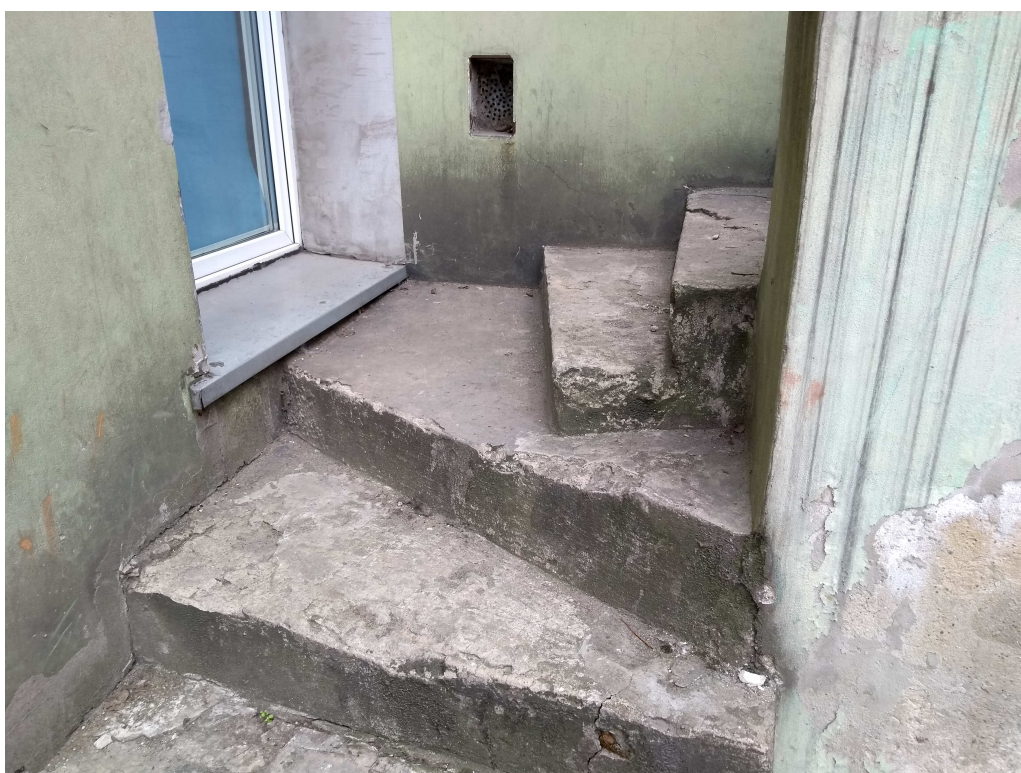
Zdjęcie narożnika zabiegowego schodów
