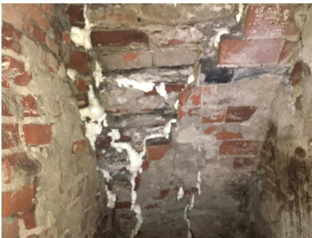
Zdjęcie dolnej części sklepienia ceglanego biegu schodów
